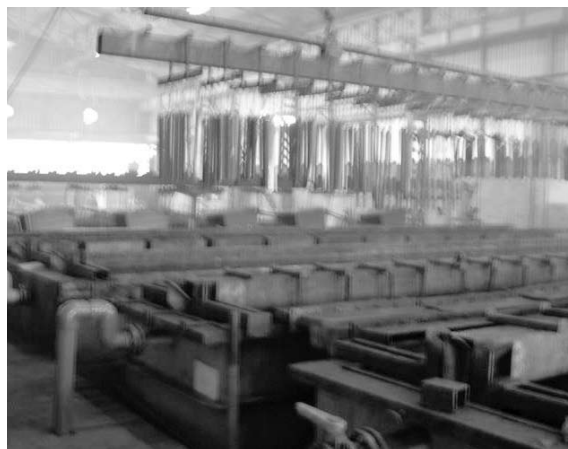
Slika 3. Pogon za pocinčavanje čelično rešetkastih stupova
