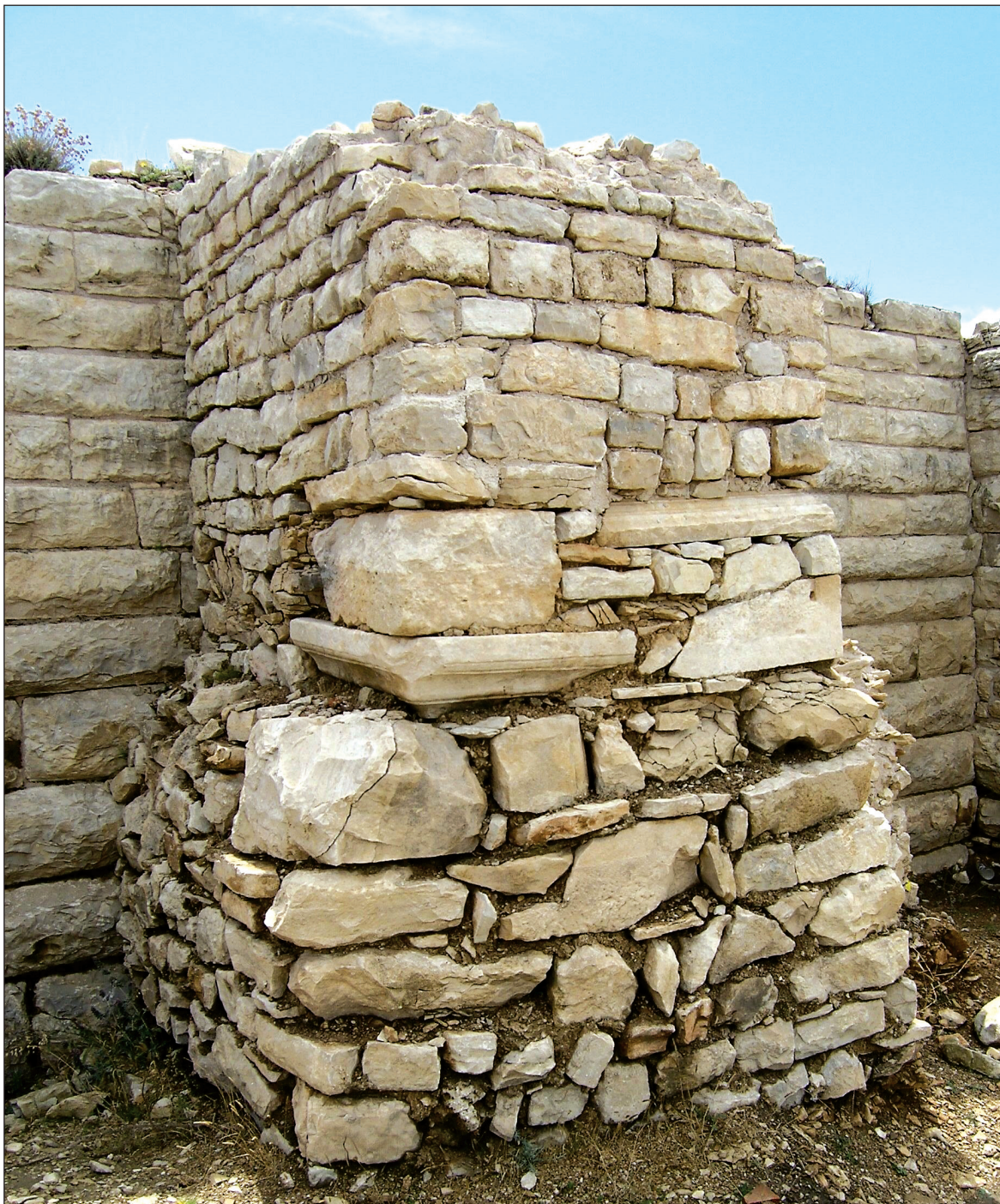
Sl. 15. Dijelovi ara unutar strukture prvoga kasnoantičkoga kontrafora
