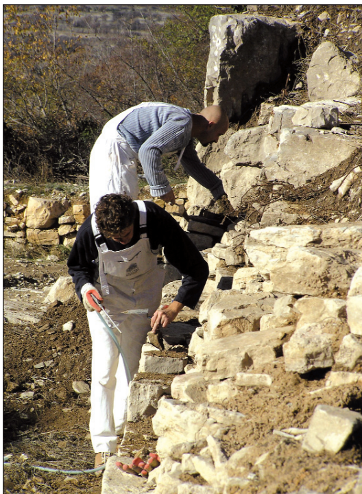
Sl. 6. Čišćenje zida na zapanom ulazu
