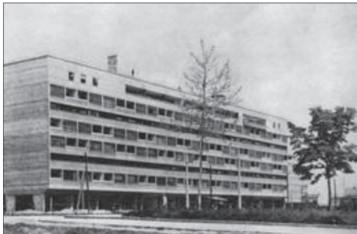
SL. 21. VIŠESTAMBENA ZGRADA, ULICA GRADA VUKOVARA 35-35A, JUŽNO PROČELJE
