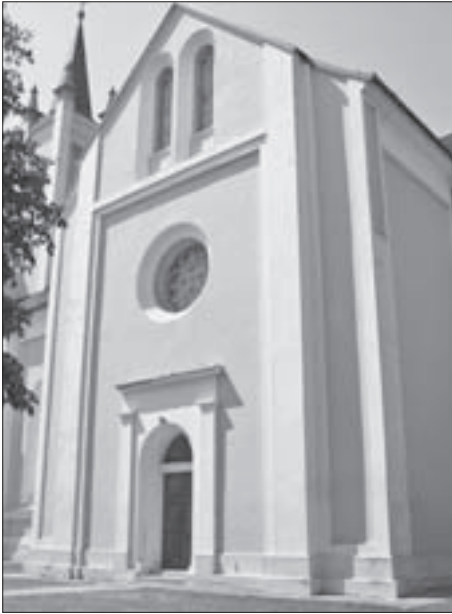
SL. 15. F. KLEIN: PROČELJE TRANSEPTA MOLVARSKE CRKVE FIG. 15 F. KLEIN: FACADE OF THE CHURCH TRANSEPT, MOLVE
