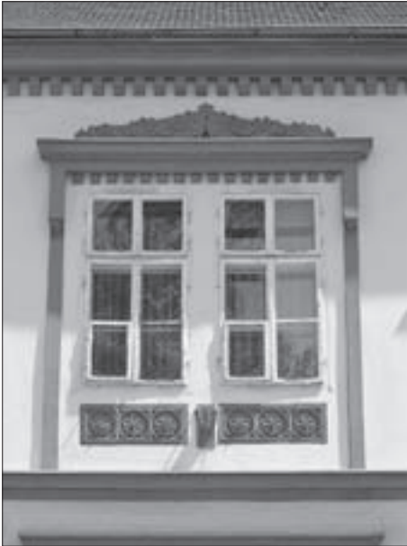
SL. 9. F. KLEIN (?): DETALJ RAŠCLAMBE SREDISNJEG PROČELJA KUĆE 1. MAJORA, BJELOVAR, GLAVNI TRG, 1855.-1856.
