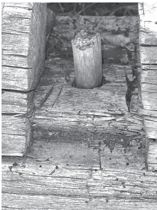
Slika 6: Mali Stolac – dijelovi uklonjene krovne konstrukcije s drvenim klinovima (snimila Ivana Šarić Žic, kolovoz 2003. godine)
