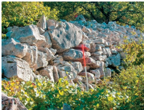
Sl. 5 Pogled na segment vanjskog lica unutrašnjeg bedema (Fotografija: Vedran Kos).
