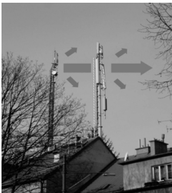
Slika 3. Primjer postavljanja bazne stanice na krovu stambene zgrade
