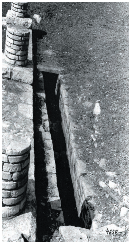
Sl. 7 Vunara, detalj, odvodni kanal
