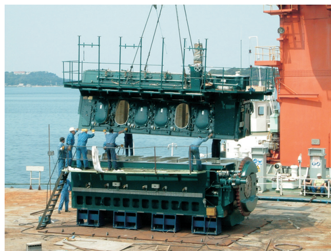
Montaža motora na Uljanikovo opremnoj obali
