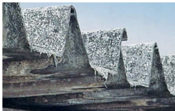
Slika 4 Snopovi azbestnih vlakana iz dotrajalih krovnih salonit-ploča
