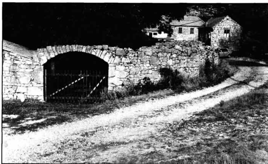
Sl. 7. Klaričevac, kuća s ogradama, stanje 1998.
