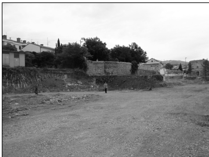
Sl. 2. Sjeveroistočni profil iskopa na kojem su utvrđeni ostatci arhitekture (foto: Arhiva GMS-a).
