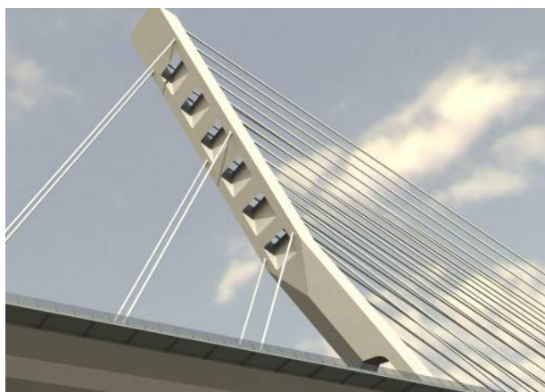
Slika 4. Pogled na pylon mosta Jarun
