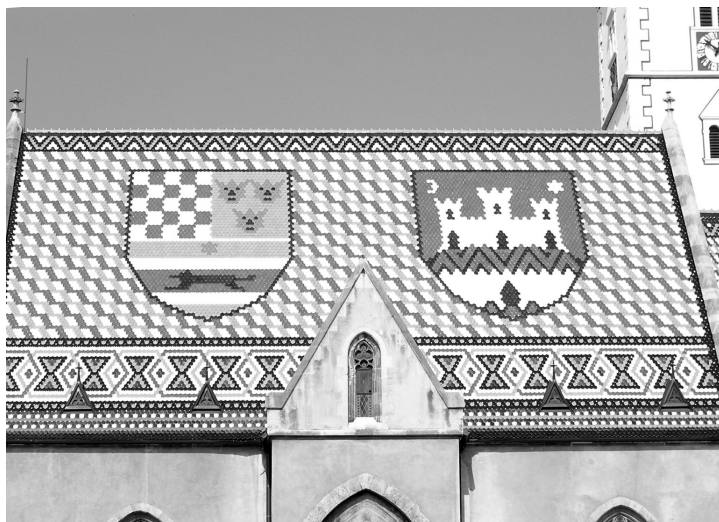
Slika 3: Južna strana krova iznad brodova župne crkve svetog Marka u Zagrebu, današnje stanje; Foto: D. Damjanović, 19. 3. 2006. /
