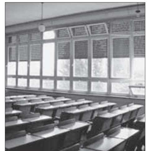
Sl. 16. INTERIJER KARAKTERISTIČNE UČIONICE JUŽNOGA TRAKTA, FOTOGRAFIJA DANAŠNJEGA STANJA Fig. 16 TYPICAL CLASSROOM OF THE SOUTH WING, INTERIOR, PHOTO OF THE PRESENT STATE
