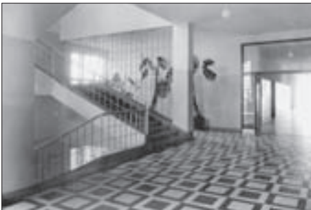
SL. 13. INTERIJER KOMUNIKACIJSKOGA TRAKTA, FOTOGRAFIJA IZVORNOGA STANJA FIG. 13 CONNECTING WING, INTERIOR, PHOTO OF THE ORIGINAL STATE
