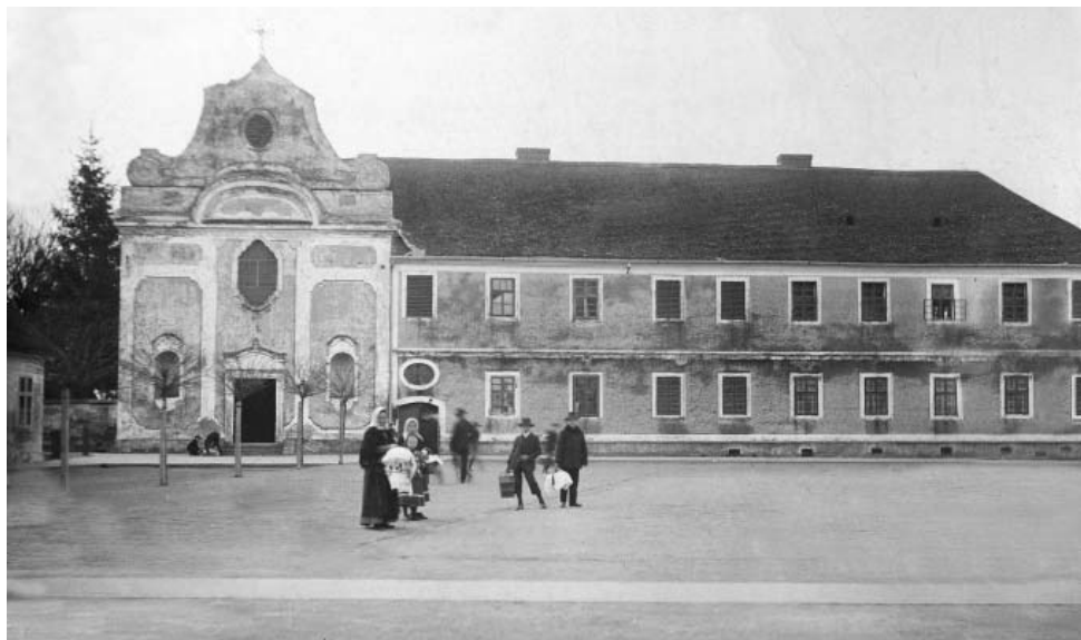
(sl. 2a) - Glavno pročelje i crkva staroga sjemeništa u Đakovu, fotografija (Arhiva Bogoslovnoga sjemeništa, Đakovo)
