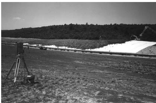
Slika 4 Odlagalište za vrijeme trajanja (postupka) sanacije
