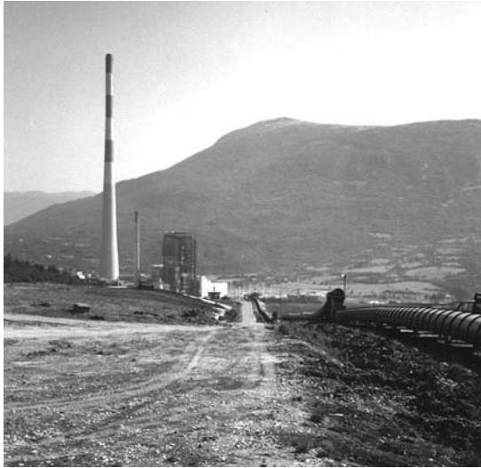
Slika 3 Odlagalište za vrijeme trajanja (postupka) sanacije
