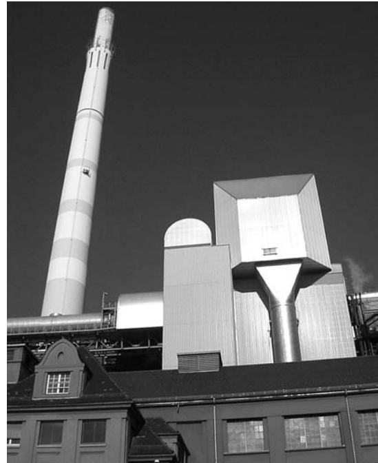
Slika 2 Spalionica komunalnog otpada u Stuttgartu
