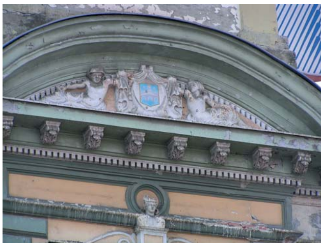
Polukružni zabat središnjeg dijela pročelja varoške kuće prema glavnom trgu; fot. D. Damjanović, 26. 2. 2009.
