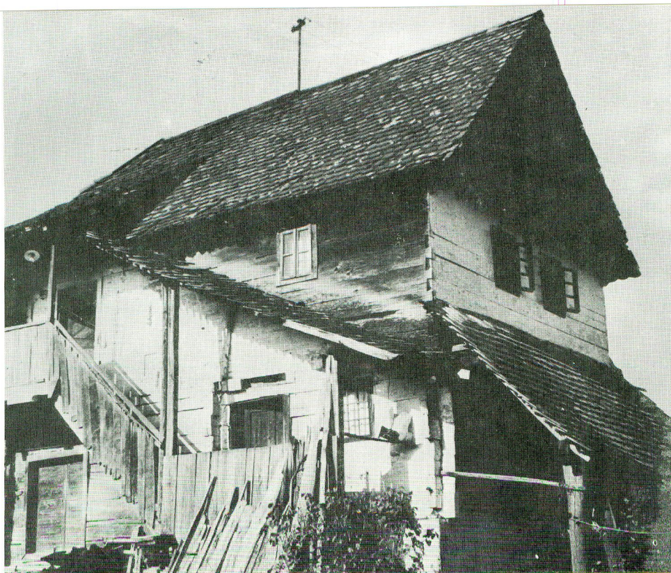
6. Čardak, zadružna kuća od oblica građena oko 1750, Lipovljani (okrug Novska), Kolodvorska ul. 42, vlasnik M. Karlovac, posjed od 14 jutara. Foto J. Vařeka, 1971.
