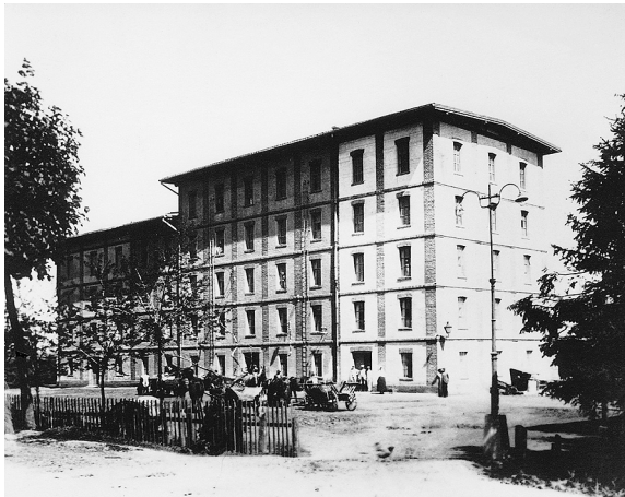
Slika 21: Koprivnički paromlin, koji i danas (uz novu tehnologiju) radi u sklopu Podravke, osnovan je 1894., a generator za proizvodnju struje dobio je najvjerojatnije već 1903. godine - glavni dioničari bili su Braun i Etinger
