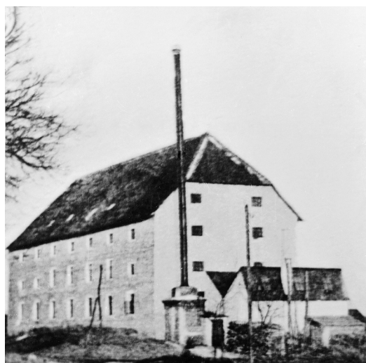
Slika 12: Poznati Braunov paromlin u Đurđevcu radio je od 1879. do 1916. godine - početkom 20. stoljeća i ovdje je bio montiran generator za dobivanje električne energije
