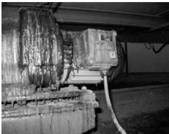
Slika 4. Loše održavanje i opće stanje elektromotora Figure 4. Poor maintenance and general condition of an electrical motor
