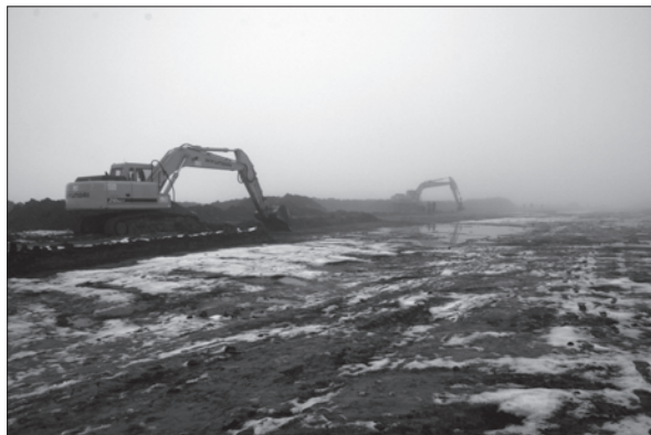
Sl. 3. Strojno skidanje humusa u zimskim uvjetima (foto: H. Kalafatić) Fig. 3 Machine removal of humus in winter conditions (photo: H. Kalafatić)
