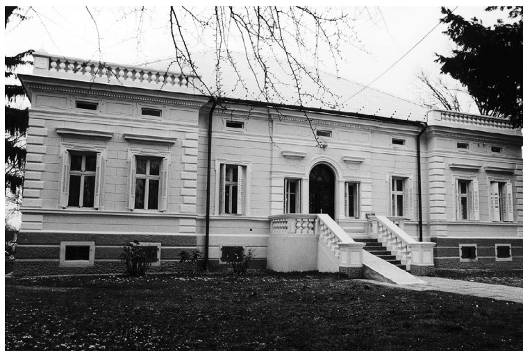
Današnji izgled Hirschlerove palače - tu se nalazi Dom zdravlja
