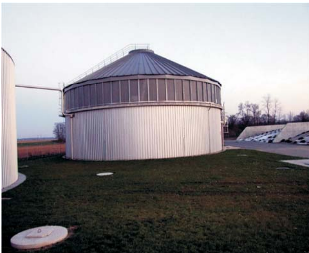
Figure 3 Gasometer in biogas industry in Nemščak, Slovenia Slika 3. Plinometar u bioplinskoj industriji u Nemščaku, Slovenija
