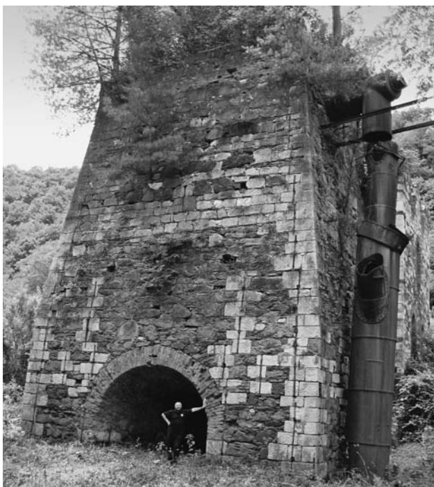
Visoka peč – Bešlinac (sagrađena ~ 1830. godine) – u budućnosti restauracija.
