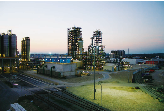
SLIKA 1. Novo postrojenje za proizvodnju polietilena niske gustoće
