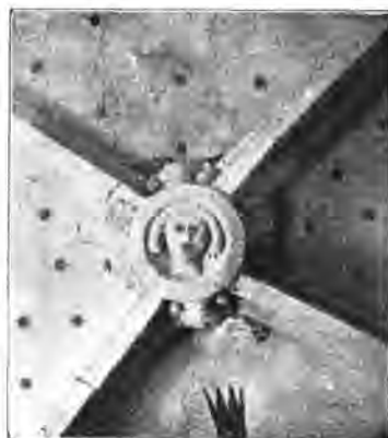
Sl. 46. Zaglavni kamen sa svoda stare župne crkve u Belcu.
