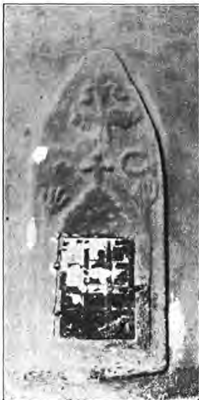
Sl. 47. Svetohranište u zidu svetišta stare župne crkve u Belcu.
