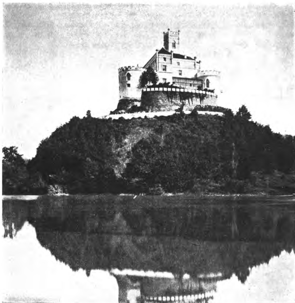
Sl. 39. Grad Trakošćan iza restauracije.
