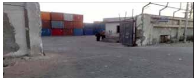
Fig (14) – Existing gate Slika 14. Postojeći pristup vratima terminala
