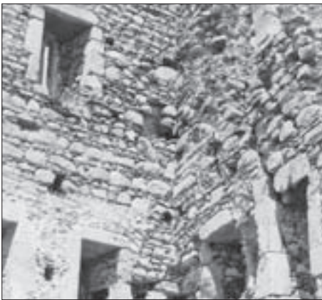
SL. 13. ČAKLOVAC, POGLED S JUGA FIG. 13 ČAKLOVAC, SOUTH VIEW
