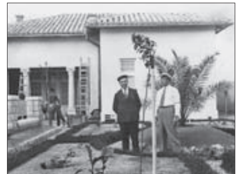
SL. 12. SJEVEROISTOČNO (DVORIŠNO) PROČELJE NAKON IZGRADNJE I UREĐENJA VRTA FIG. 12 NORTHEAST (COURT-FACING) FAÇADE, AFTER THE CREATION OF GARDEN
