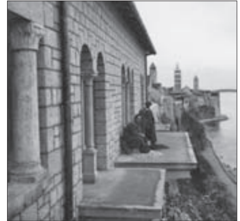
SL. 11. POGLED SA SJEVERA NA MORSKO PROČELJE PREMA JUGU. BALKONI U IZGRADNJI, BEZ OGRADE I ZAVRŠNE OBLOGE. E. STEINMANN (SJEDI) NA SREDNJEM BALKONU. FIG. 11 NORTH VIEW OF THE SEA-FACING FAÇADE; CONSTRUCTION OF BALCONIES WITHOUT FENCES AND FINALISATION; E. STEINMANN (SITTING) ON THE MIDDLE BALCONY
