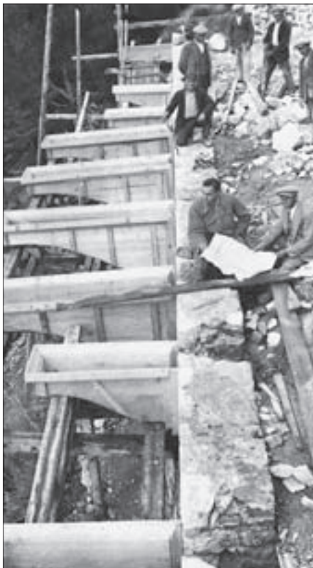
SL. 10. IZVEDBA ARMIRANOBETONSKIH KONZOLA ZA BALKONE. E. STEINMANN S NACRTOM (SJEDI U PRVOM PLANU) NA GRADILISTU. FIG. 10 EXECUTION OF REINFORCED CONCRETE CANTILEVER BALCONIES. IN THE FOREGROUND E. STEINMANN WITH THE BLUEPRINT ON THE CONSTRUCTION SITE
