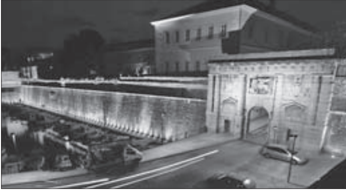
SL. 4. ZADAR – OSVJETLJENJE LUČICE FOŠE FIG. 4 ZADAR – LIGHTING SCHEME OF THE PORT OF FOŠA
