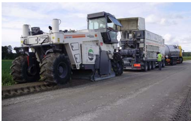
Slika 8. Vlak za recikliranje na državnoj cesti D55 (Foto: Reteh d.o.o., G. Crnić)
