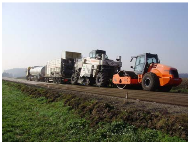
Slika 7. Vlak za recikliranje na državnoj cesti D55 (Foto: Reteh d.o.o., G. Crnić)
