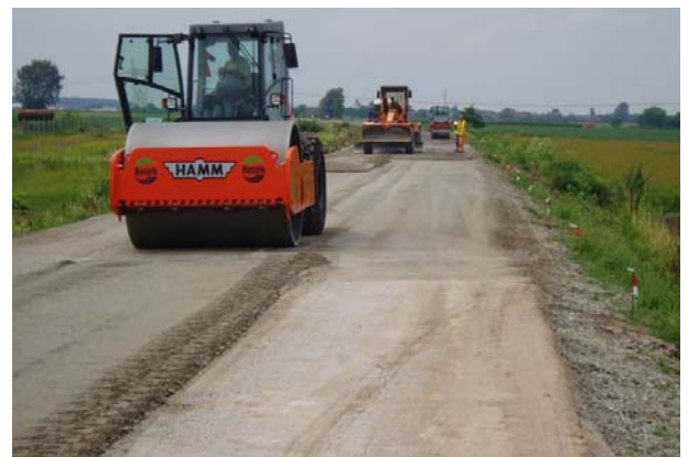
Slika 4. Faza zbijanja hladno recikliranog sloja na državnoj cesti D55 (Vinkovci - Županja)
