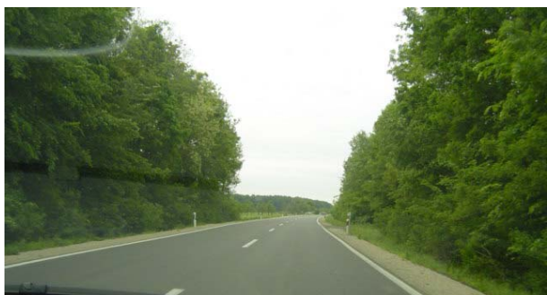
Slika 9. Dobar izgled pokrovnog sloja zastora kolnika položenog na hladno recikliranu podlogu na Državnoj cesti D55
