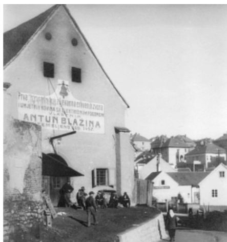
Slika 6. Kaptolska zvonoljevaonica vlasnika Antuna Blazina. Blazina je bio vlasnik te zvonoljevaonice u razdoblju 1909.–1930., pa se može zaključiti da su obje fotografije iz tog doba. Vjerojatno je desna fotografija mlađa, jer je ulazni plato ozidan. Na obje fotografije vide se ista oštećenja na lijevom zidu. (lijeva fotografija je iz knjige Zvona autora Ivana Bosilja, a desna iz članka Zvona zagrebačke prvostolnice autorice S. Line Slavice Plukavec)
