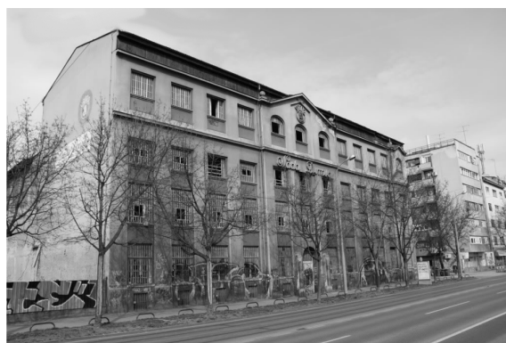
Slika 4. Zgrada nekadašnje tvornice Penkala-Moster d.d. danas. Poslije Drugog svjetskog rata tu je bila Tvornica trikotaže i pozamenterije 2 Nada Dimić . Godine 1993. to državno poduzeće pretvoreno je u dioničko društvo Endi International , a godine 2000. započeo je stečajni postupak. Danas je zgrada devastirana i zapuštena. (izvor: internet)
