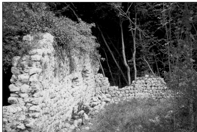
sl. 1 Sačuvani ugaoni spoj užeg zapadnog i longitudinalnog sjevernog zida sakralne građevine u blizini uvale Blatna
