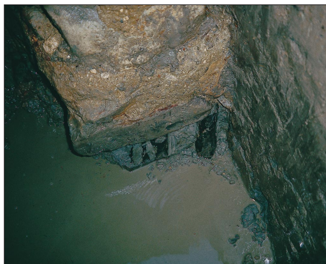
sl. 10 Prokop nasipa uz četvratstu, ulaznu kulu, snimio K. Filipec
