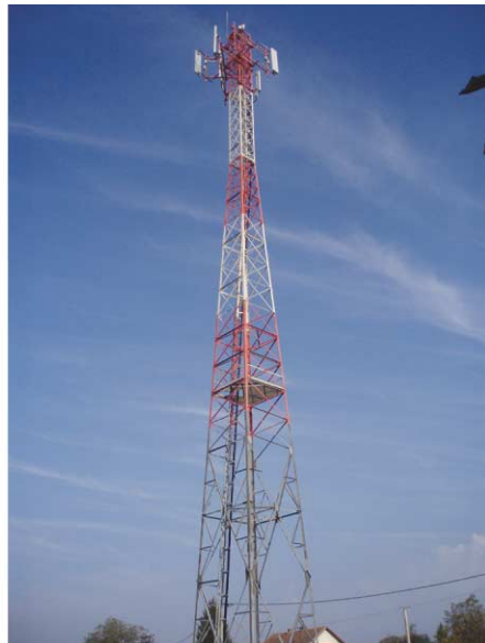
Slika 2. Stup rešetkaste konstrukcije.
