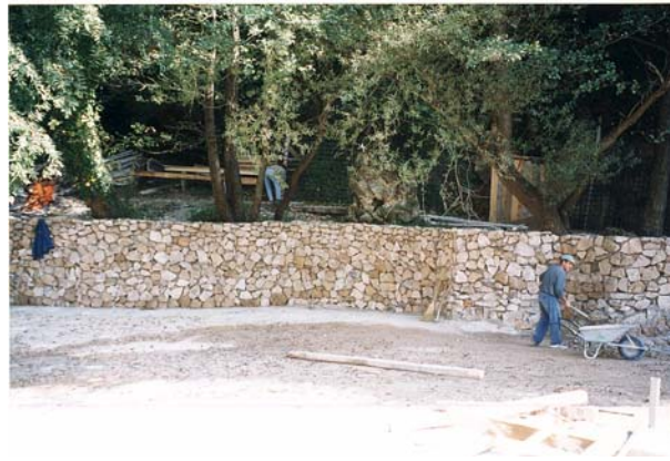
Slika 4. Radovi interventne sanacije na lijevoj obali 1997. godine [5]
