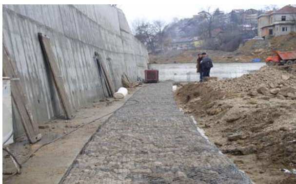
Slika 5. Radovi na sanaciji korita između pragova 7 i 8 2004.-2005. godine [6]
