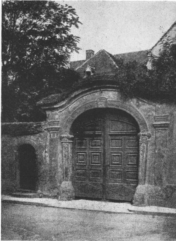
Zagreb, Demetrova ulica br. 11. Glavna ulazna vrata u dvorište.
