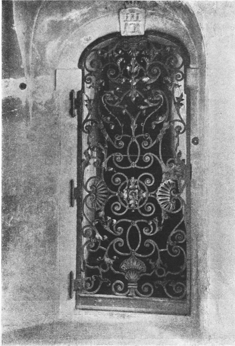
32. Ulazna vrata u kulu u prizemlju Kamenitih vrata u Zagrebu. aročna željezna rešetka iz prve polovine XVIII. stoljeća.
