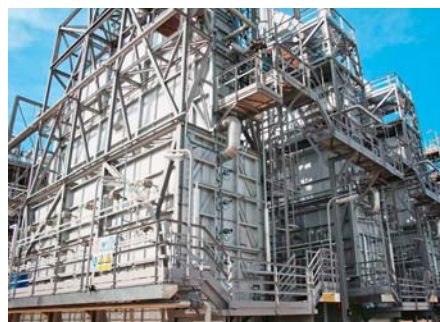
Novo postrojenje za proizvodnju vinil-klorida u DINA-Petrokemiji
