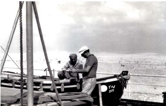
Slika 9. Sueski kanal – čakule s barkariolom Dvije barke služe za vez u kanalu. Uz kanal na jednakim razmacima su bitve (kolone) vidi se na fotografiji lijevo od Arapa. Fig. 9. Suez Canal – chat with boat-ride man Two boats for the berth in canal. Along canal there are the bits (bollards) at regular intervals as seen on the photo, left from an Arabian
