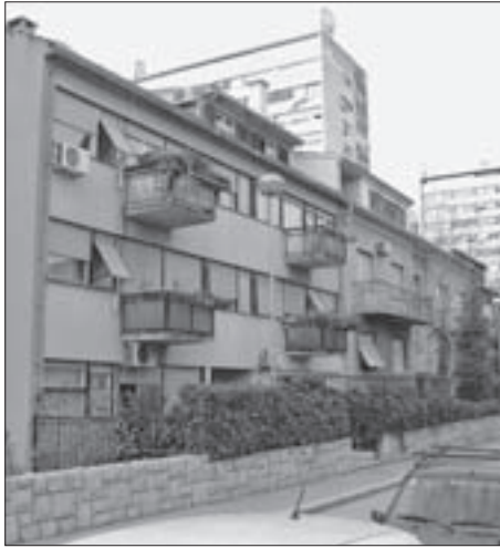
SL. 4. TIPSKA ZGRADA, TRŠĆANSKA 37, POGLED S JUGA, U PRODUŽETKU SE VIDI ZATEČENA IZGRADNJA FIG. 4 STANDARDIZED BUILDING, 37 TRŠĆANSKA STREET, SOUTH VIEW, EXISTING STRUCTURES SEEN IN THE BACKGROUND
