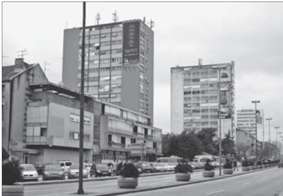
SL. 16. STAMBENO-POSLOVNA ZGRADA, ULICA DOMOVINSKOG RATA 62, POGLED SA SJVEROZAPADA, FOTOGRAFIJA SADAŠNJEG STANJA
