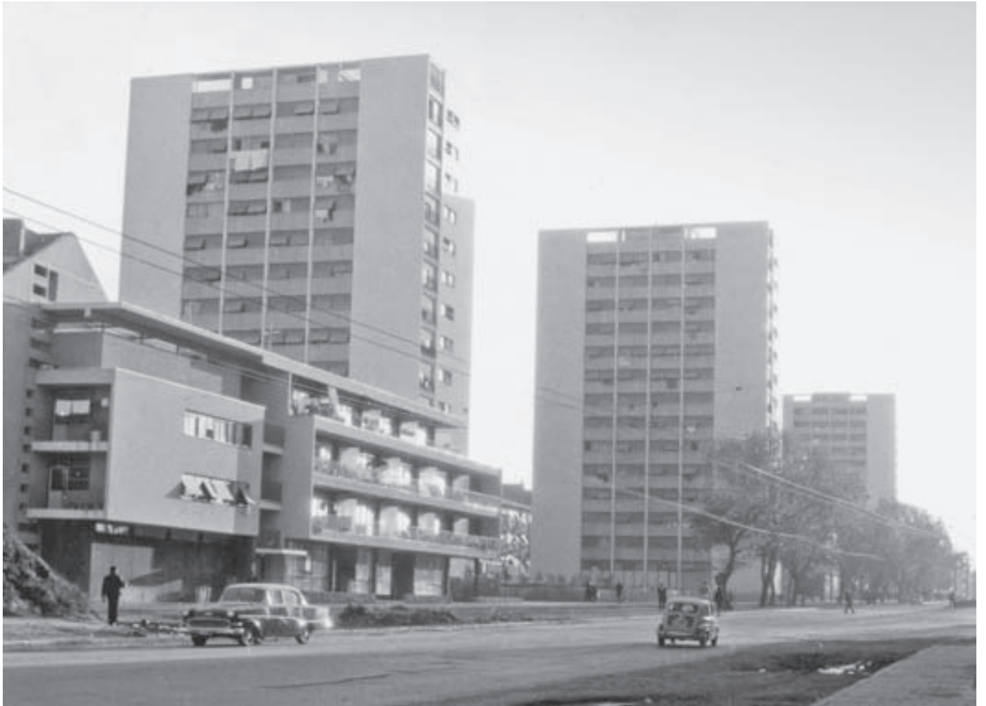
Sl. 1. STAMBENO-POSLOVNA ZGRADA, ULICA DOMOVINSKOG RATA 62, SPLIT, POGLED SA SJEVEROZAPADA, FOTOGRAFIJA IZVORNOG STANJA SNIMLJENA 1965. GODINE FIG. 1 RESIDENTIAL AND COMMERCIAL BUILDING, 62 DOMOVINSKOG RATA STREET, SPLIT, NORTH-WEST VIEW, ORIGINAL STATE, PHOTOGRAPH FROM 1965
