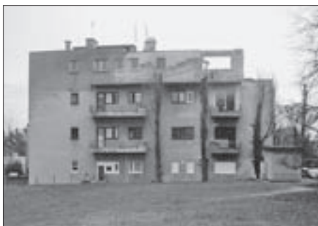
SL. 15. NOVAKOVA 32, BOČNO PROČELJE, POGLED SA SJEVERA, 2010. FIG. 15 32 NOVAKOVA STREET, LATERAL FAÇADE, NORTH VIEW, 2010
