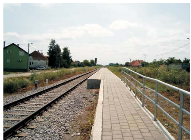
Figure 6 Insular platform in train stop Laslovo/Korođ Slika 6. Otočni peron u stajalištu Laslovo/Korođ
