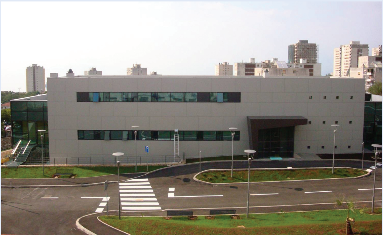
Slika 4. Nova reprezentativna zgrada Zavoda za nefrologiju i dijalizu na lokalitetu Sušak Kliničkog bolničkog centra u Rijeci i nastavne baze Medicinskog fakulteta Sveučilišta u Rijeci.
