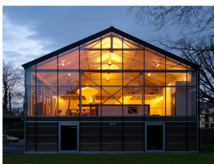
Slika 18a - Obiteljska kuća- Asse, Belgija
