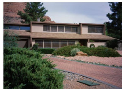
Slika 8b - Obiteljska kuća - Sedona, Arizona (SAD)
