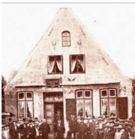
Sl.1: Mommsenova rodna kuća u Gardingu
